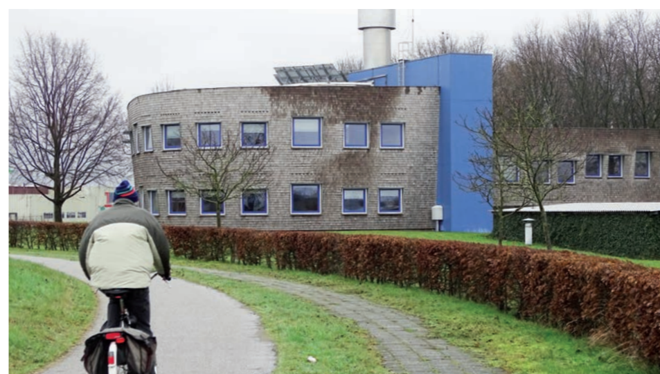
Het inmiddels gesloopte Rijkswaterstaat-kantoor in Terneuzen
