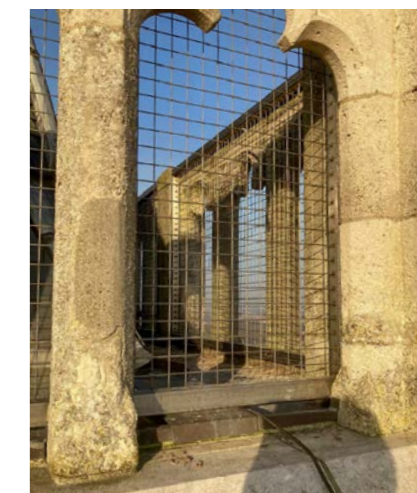
De hekwerkjes op de omloop zijn vervangen
