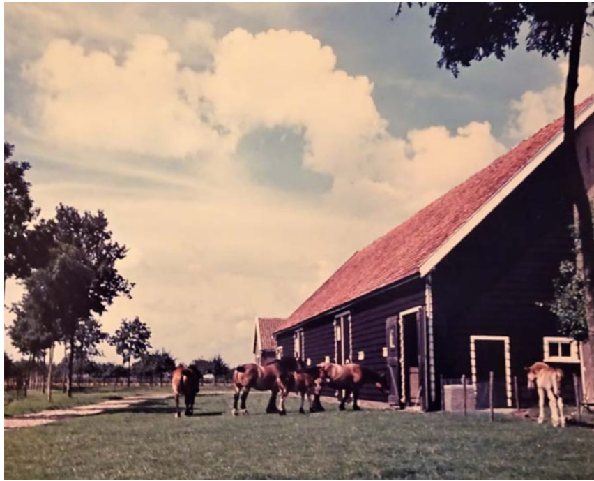
Bovenste foto: Middenhof vóór 1930 en daaronder vóór 1950 Onderste foto: de huidige aanblik van Middenhof
